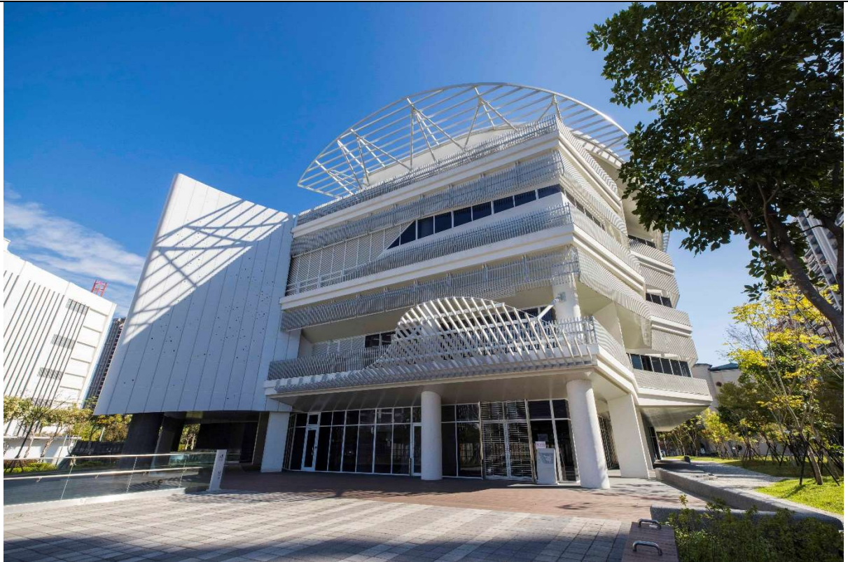
文藝路入口戶外廣場空間照片
